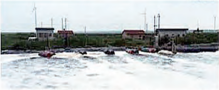
畜産廃水の浄化(酸化池100,000m 3 )
