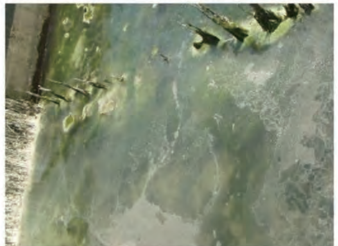
2005/05/26 (施工時) 測点 4 東丁字付近 (Installation)
