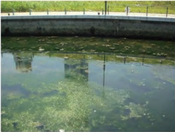
2005/05/26 (施工時) 測点 4 東丁字付近 (Installation)
