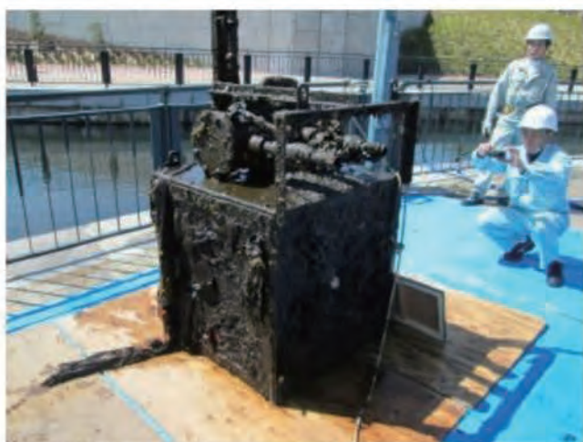
2013/03/22 pumping apparatus Before Maintenance メンテナンス前 装置引揚
