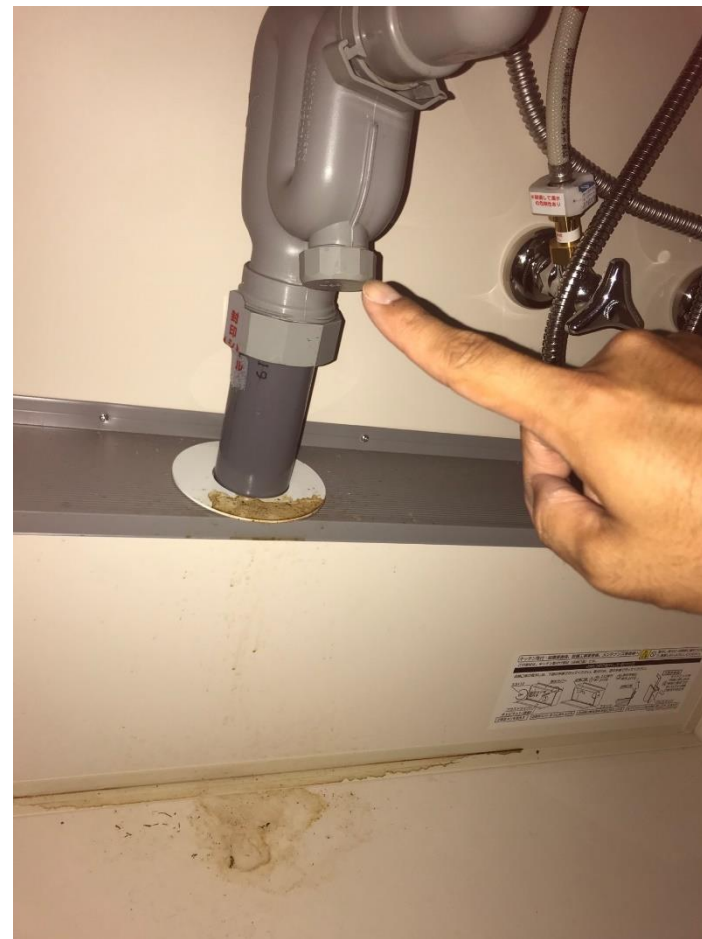
排水管からの水漏れによる汚れ
