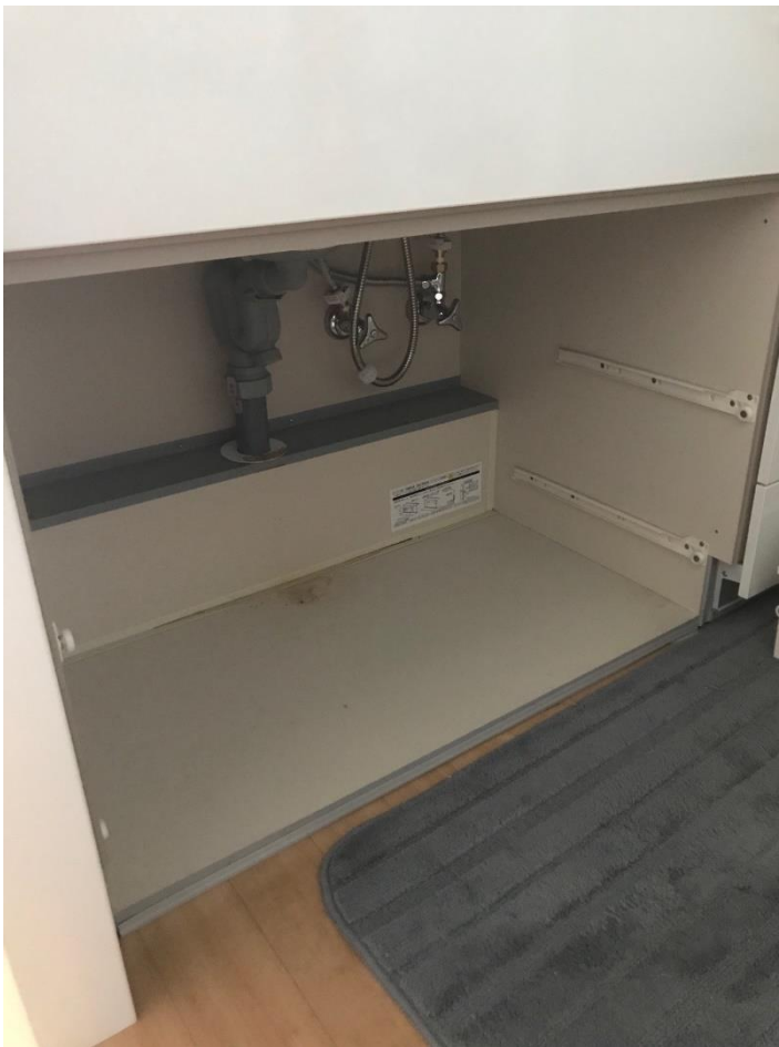
排水管からの水漏れによる汚れ
