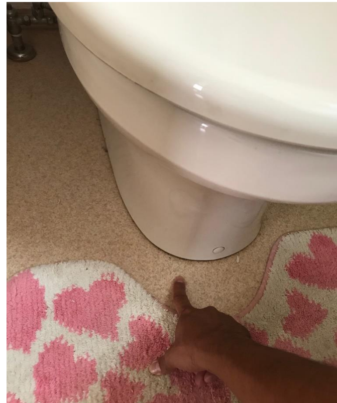
便器と床との接合部分
